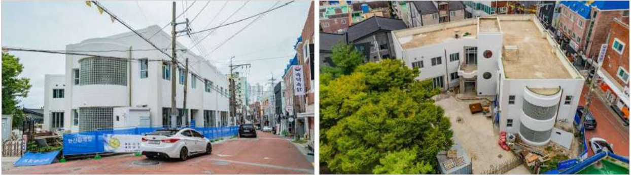
실제 공간 : 공사 중인 신어아트센터
